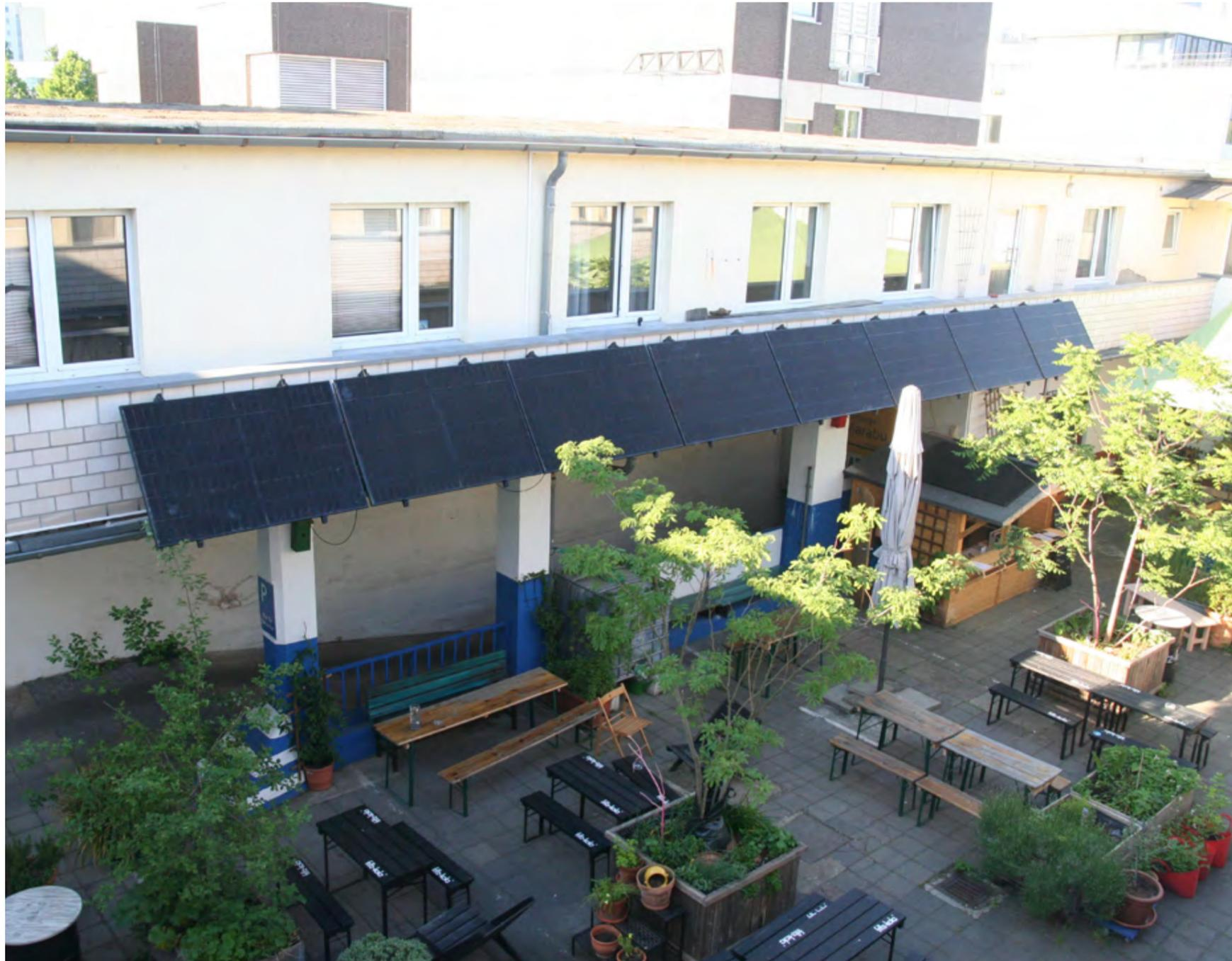
Insgesamt 11 Trina Solar 440 W bifaziale Glass-Glass Module mit insgesamt 4,84 kWp:
